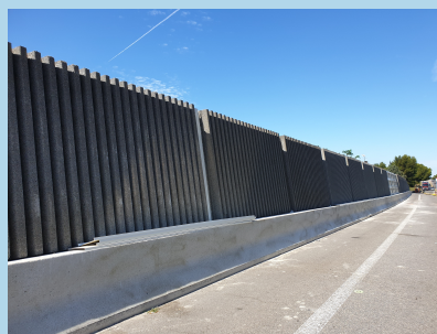
Vue avant, à quelques jours de la fin des travaux
